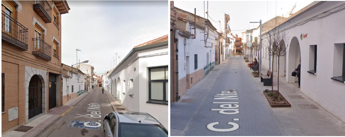
Figura 3: Actuación en C/ del Norte realizada en 2023. Antes y después
